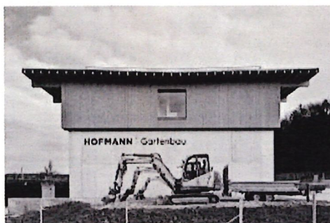
60391 Gartenbau-Werkhof in Winterthur
