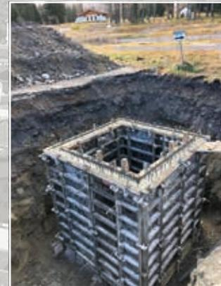
Élargissement du couronnement de la prise d'eau de La Fouly permettant le passage des eaux usées et de l'électricité
