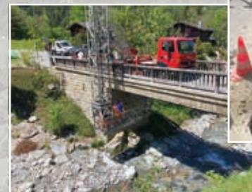
Le Revers : changement de la conduite d'eau potable qui passe sous le pont
