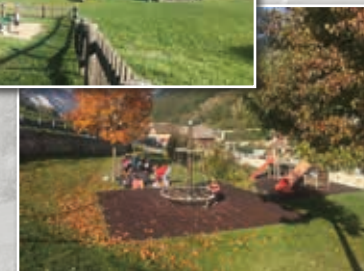
Cœur d'Orsières : les travaux concernant le parking et la place de jeux ont débuté à la mi-octobre
