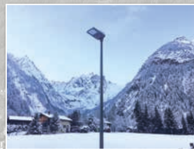
Passage de l'éclairage traditionnel au LED permettant l'abaissement de la luminosité de 80 % de 22h00 à 6h00
