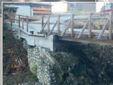
Réfection et consolidation du pont de Somlaproz
